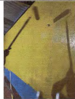
Foto 6: Pintura de muros exteriores e interiores
