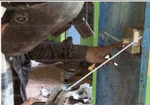
Foto 3: Sustitución de chapa
