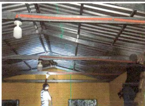
Foto 11: Sustitución de focos ahorradores y plafoneras y cableado eléctrico.
