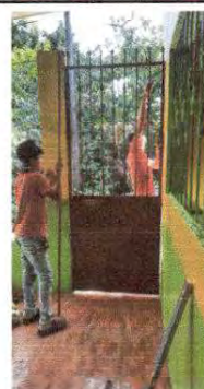
Foto 14: Fabricación e instalaciones de puerta de rejas
