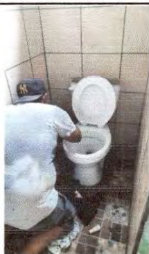
Foto7: Sustitución de inodoro y azulejo
