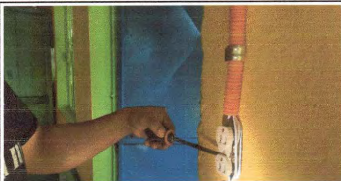
Foto13: Sustitución de tomacorrientes dobles
