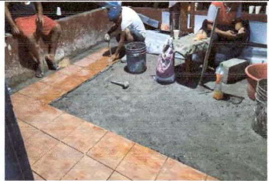
Foto 4: Sustitución de piso de cemento liquido por piso ceramico en aulas, corredor y baños.
