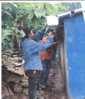
Foto 5: Sustitución de canal de pvc, pescantes, bajadas de agua pluvial
