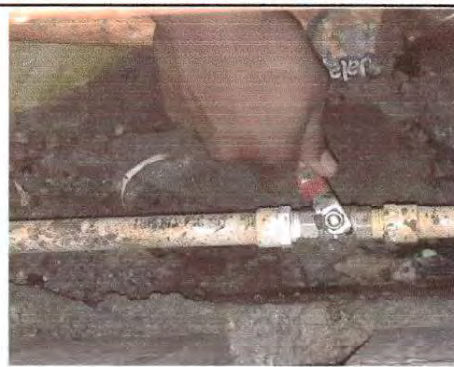
Foto 8: Sustitución de llave de cheque
