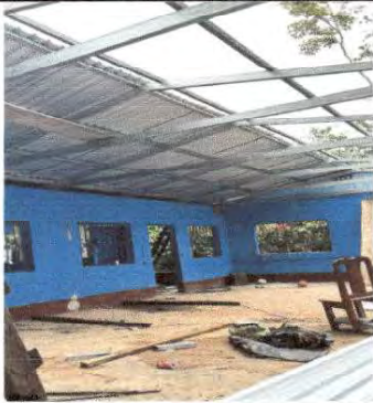
Foto1:Sustitución de lamina, capote, elementos de fijación.
