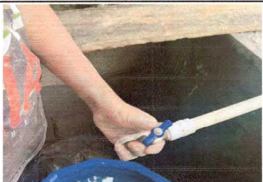
Foto 9: Sustitución de llave de chorro
