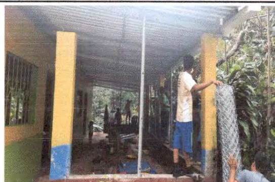
Foto 10: Reparación de tubo hg y malla galvanizada.
